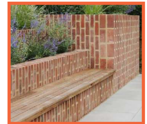
Кирпичная подпорная стенка Обрамляет вход в парк и направляет вдоль основных транзитов. На ней расположены места для сидения, ориентированные на площадь.
